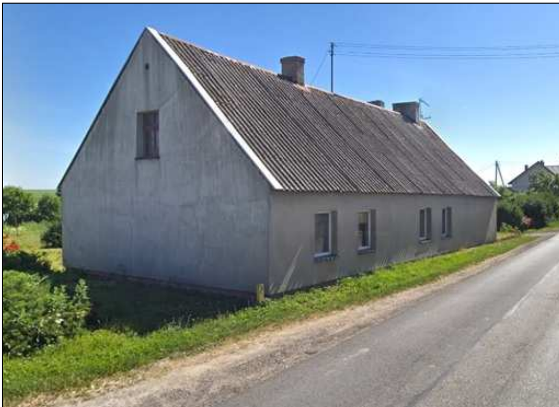
Fot. 2 Budynek w km ok. 109+740 strona lewa m. Dziedno (dz. 96/2)
