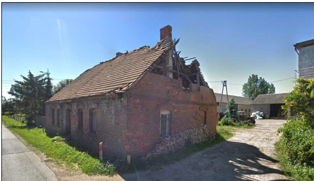
Fot. 1 Budynek w km ok. 109+700 strona prawa m. Dziedno (dz. 101/1)
