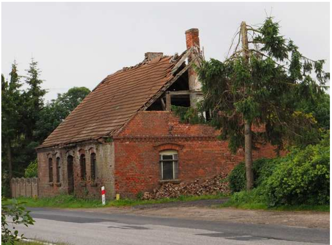
Fot. 4 Budynek do rozbiórki w wariantcie 2 ok. km 109+683 strona prawa m. Dziedno
