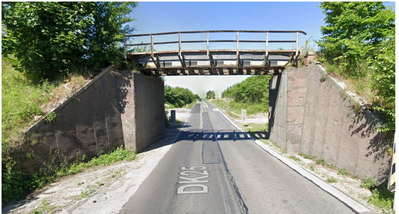
Fot. 3 Wiadukt do rozbiórki km 107+832
