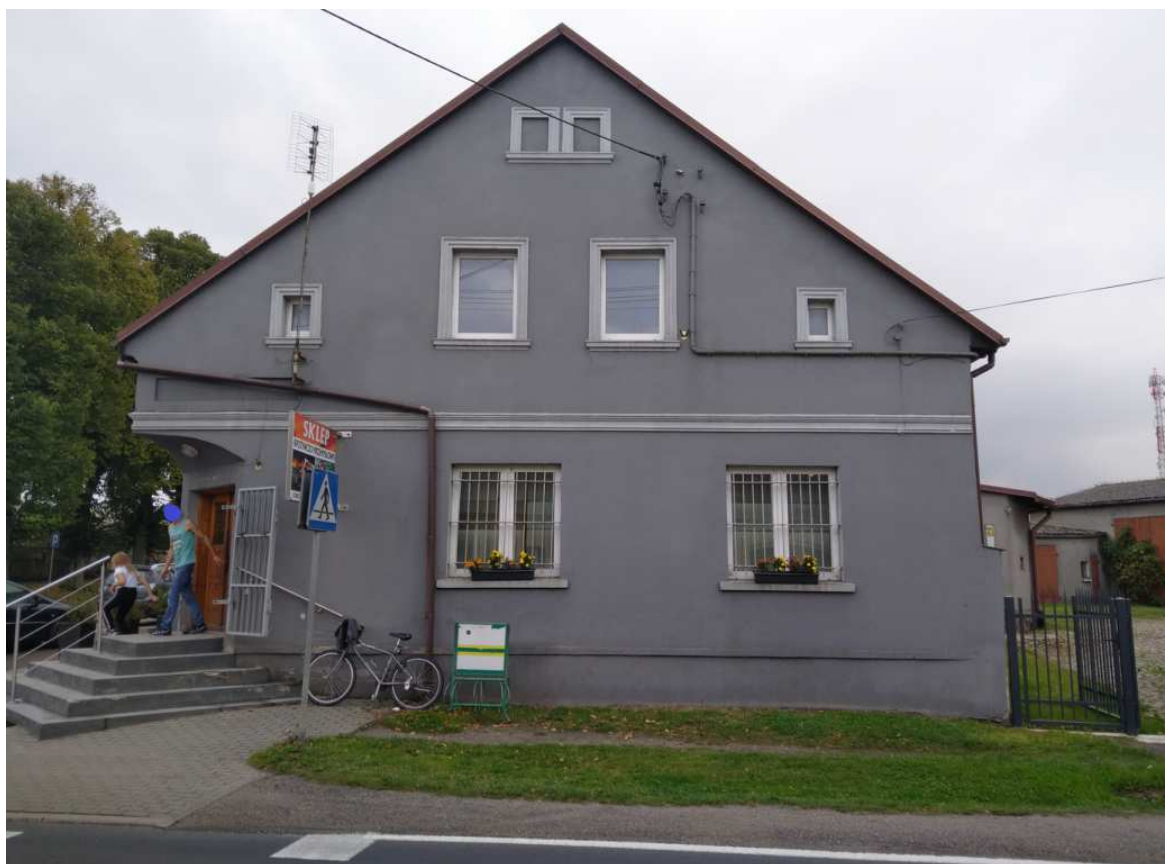
Fot. 8 Budynek na działce nr 473, elewacja od strony DK25. Na kondygnacji mieszkalnej (drugiej) widoczne nowe okna PVC
