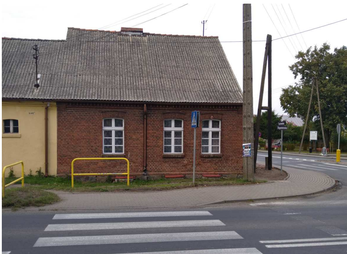
Fot. 9 Budynek na działce nr 480/2, elewacja od strony DK25. Widoczne okna starego typu w dobrym stanie
