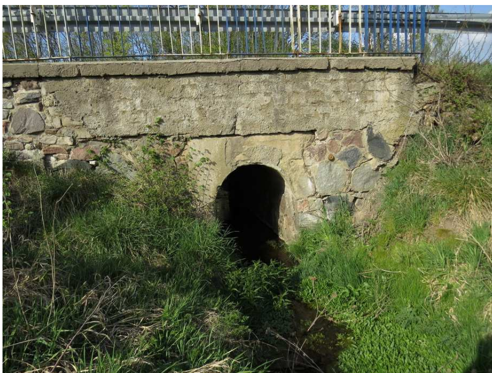
Fot. 10. Przepust pod drogą krajową nr 25 na wschód od Obodowa.
