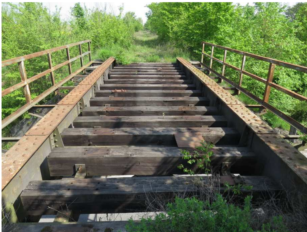
Fot. 11. Wiadukt kolejowy nad drogą krajową nr 25 prowadzący do nieczynnej stacji PKP Obodowo.
