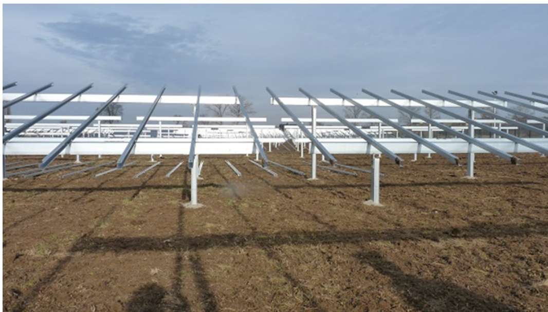
Ryc. 7. Konstrukcja stalowa stelaży pod moduły fotowoltaiczne
