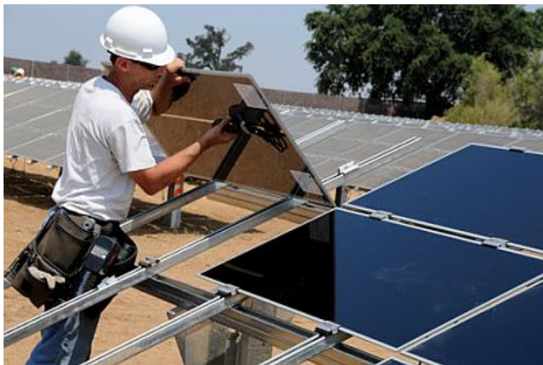
Ryc. 8. Montaż modułów na stelażach – przykład
