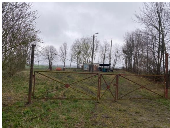
Fot. 8 Dawna stacja paliw, bufor inwestycji
