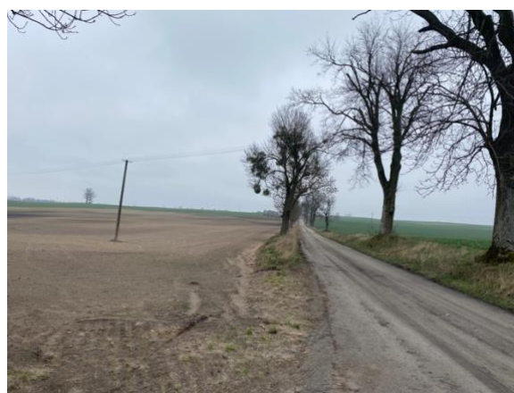
Fot. 10 Widok z drogi gruntowej na tereny inwestycyjne
