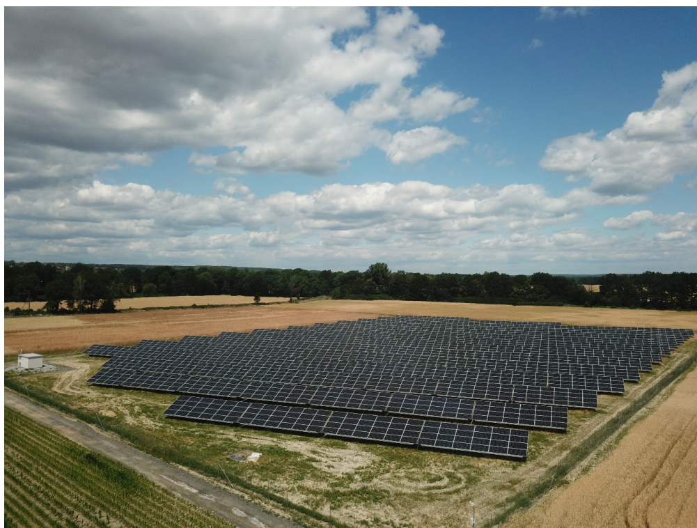
Fot. 1. Przykładowe zagospodarowanie terenu pod oraz pomiędzy rzędami stołów fotowoltaicznych
