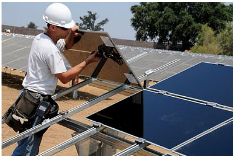
Ryc. 8. Montaż modułów na stelażach – przykład
