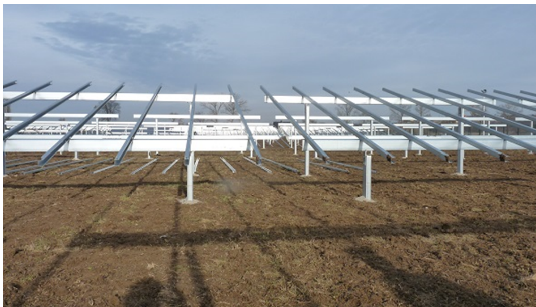
Ryc. 7. Konstrukcja stalowa stelaży pod moduły fotowoltaiczne
