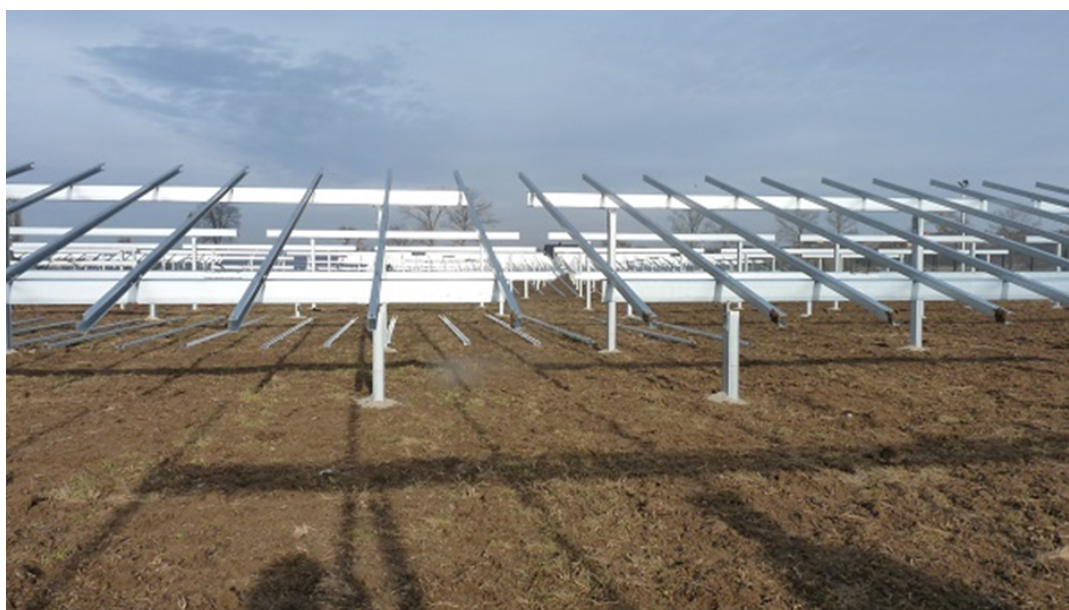
Ryc. 7. Konstrukcja stalowa stelaży pod moduły fotowoltaiczne
