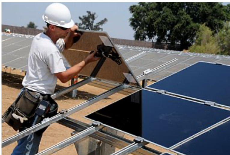
Ryc. 8. Montaż modułów na stelażach – przykład
