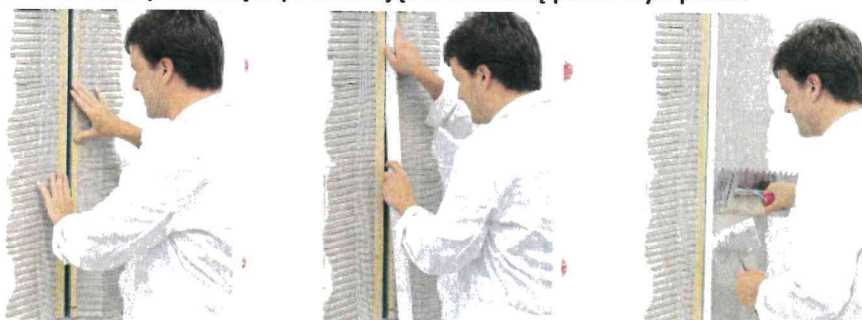
Rys. 24. Schemat układania profilu dylatacyjnego
