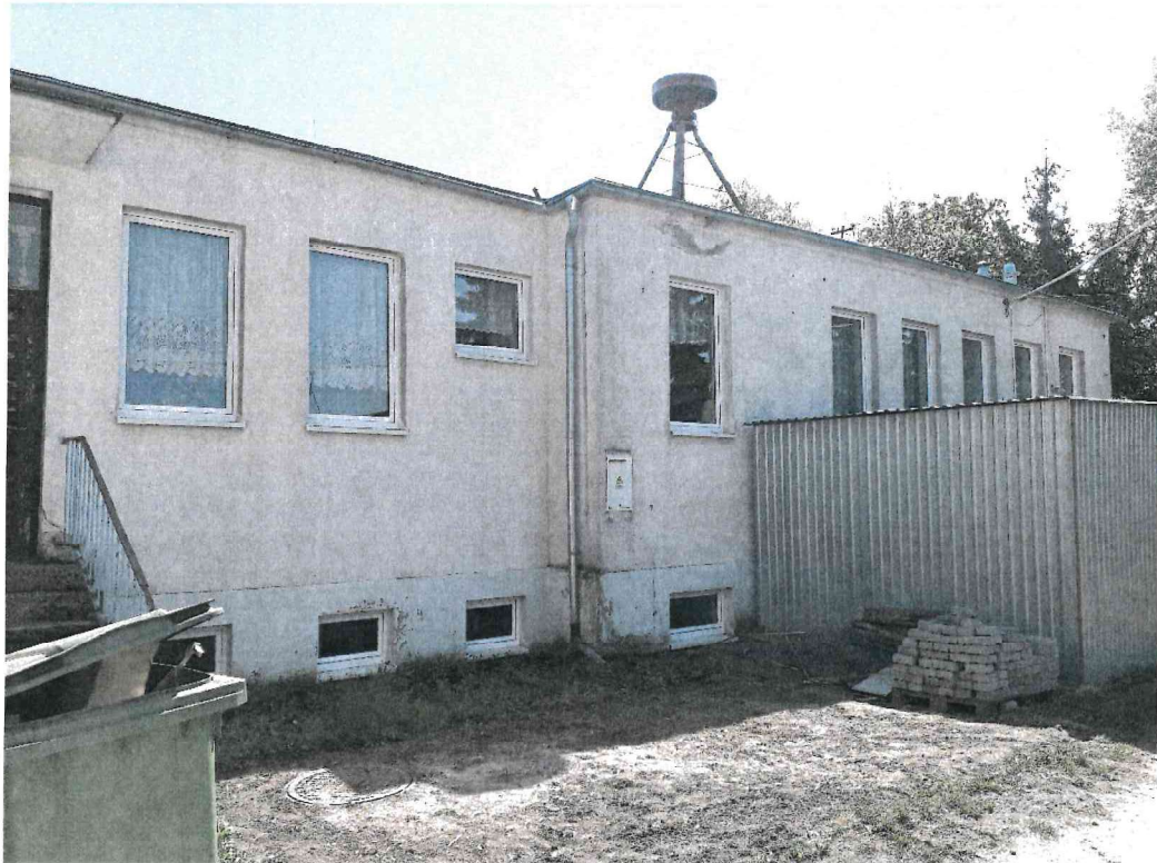
Zdj. 3. Elewacja północna
