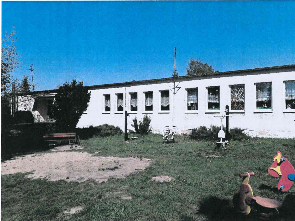
Zdj. 1. Elewacja zachodnia (frontowa)
