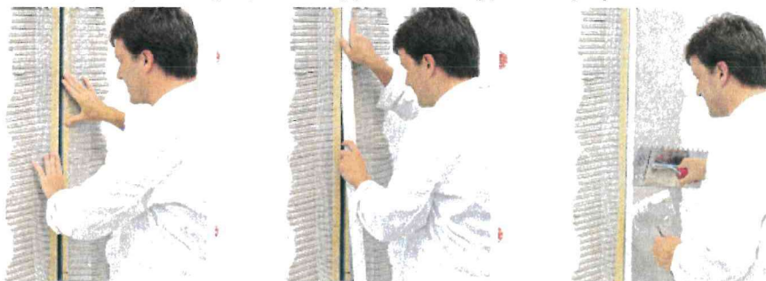
Rys. 16. Schemat układania profilu dylatacyjnego
