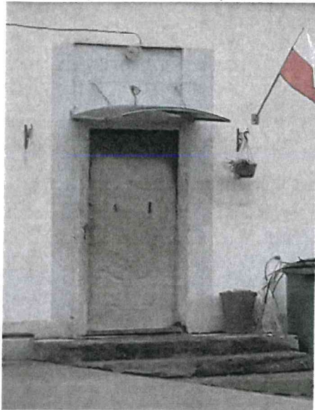
Fot. 4. Drzwi na elewacji wschodniej
