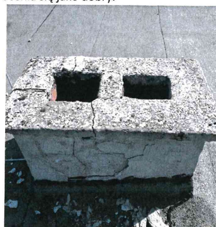
Fot. 3. Komin wentylacyjny
