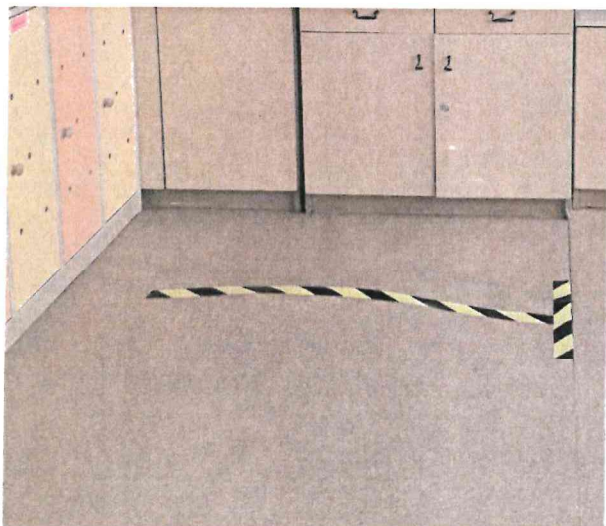
Fot. 7. Posadzka w szatni
