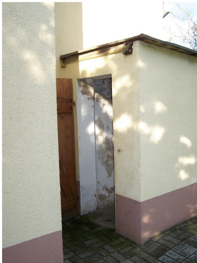
Rysunek 11. Zewnętrzna toaleta świetlicy w Wielowiczu
