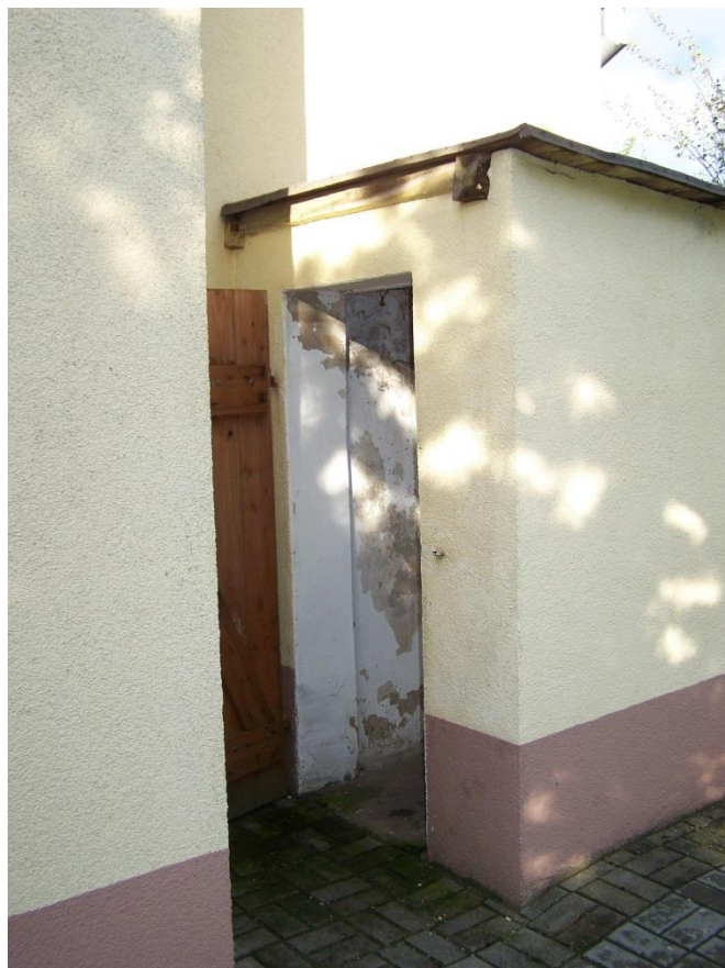
Rysunek 11. Zewnętrzna toaleta świetlicy w Wielowiczu
