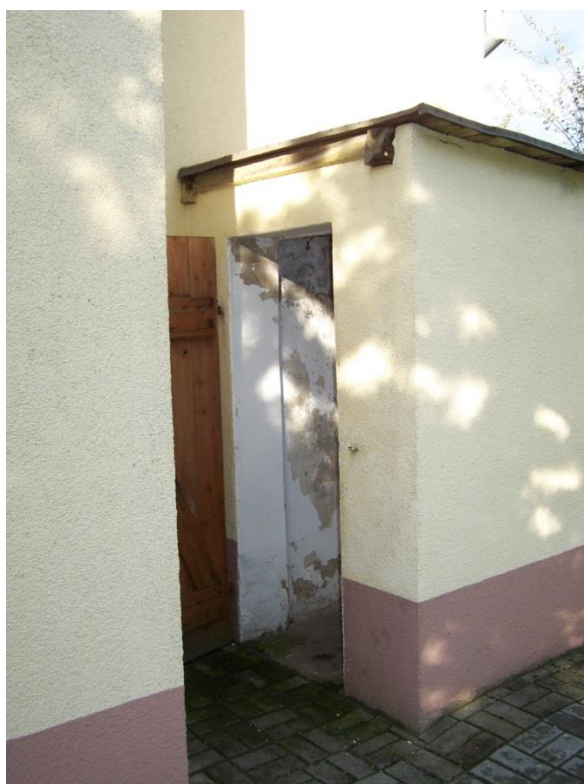
Rysunek 13 Zewnętrzna toaleta świetlicy w Wielowiczu (źródło: Urząd Gminy Sośno)
