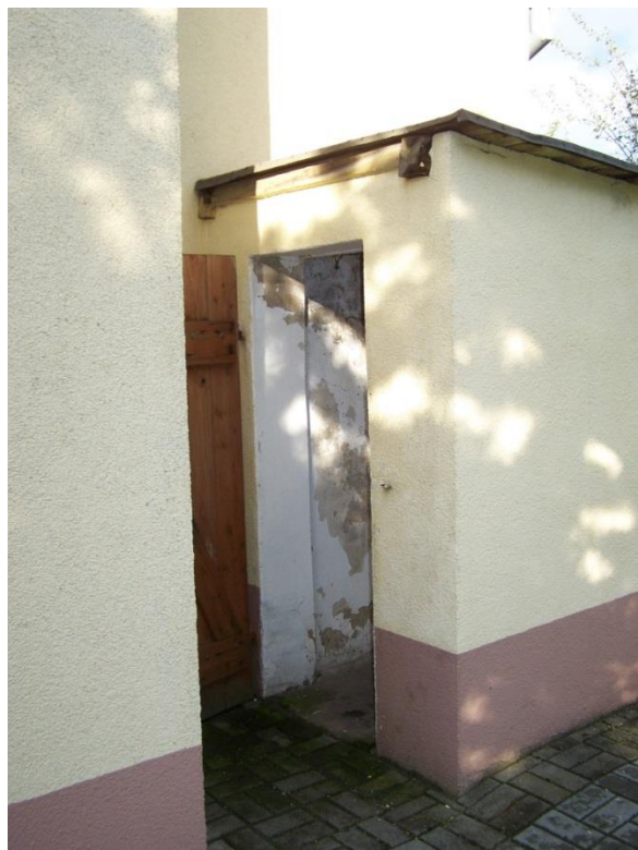
Rysunek 12 Zewnętrzna toaleta świetlicy w Wielowiczu (źródło: Urząd Gminy Sośno)
