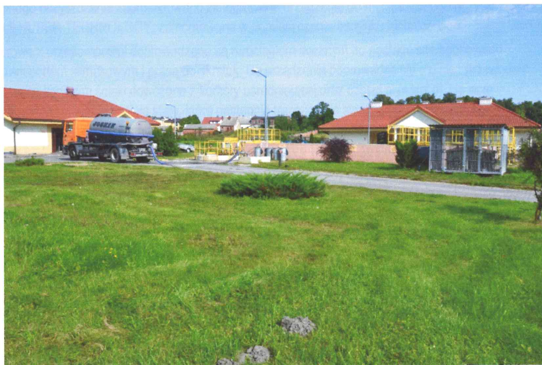
Fot. 2. Teren oczyszczalni: po prawej budynek socjalno - techniczny, po lewej budynek techniczny
